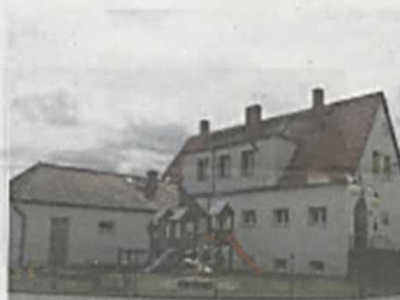
Remont przedszkola w Męcince
