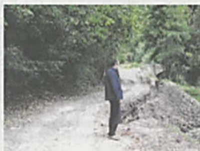
Obecnie trwa odbudowa drogi w Kondratowie
