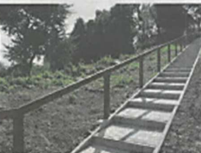
Budowa chodnika w Słupie
