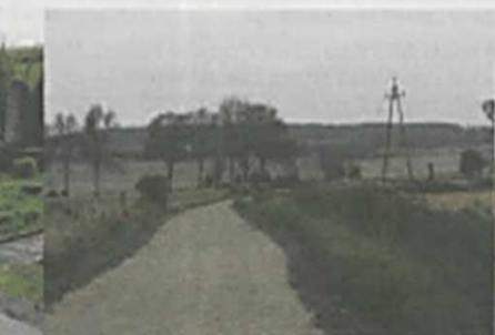
Obecnie trwa odbudowa drogi w Męcince
