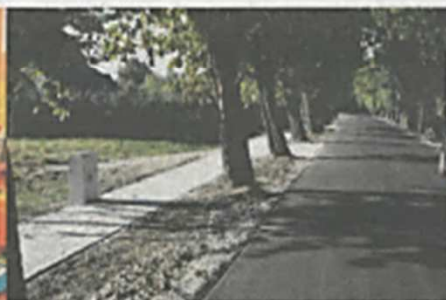
Odbudowa drogi i budowa chodnika w Piotrowicach
