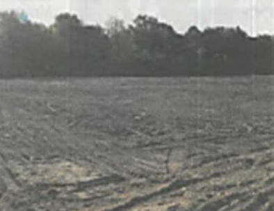
Budowa boiska w Sichowie
