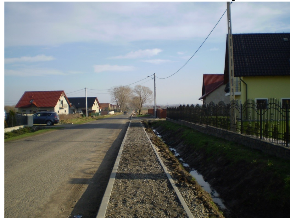
Chodnik w trakcie realizacji.
